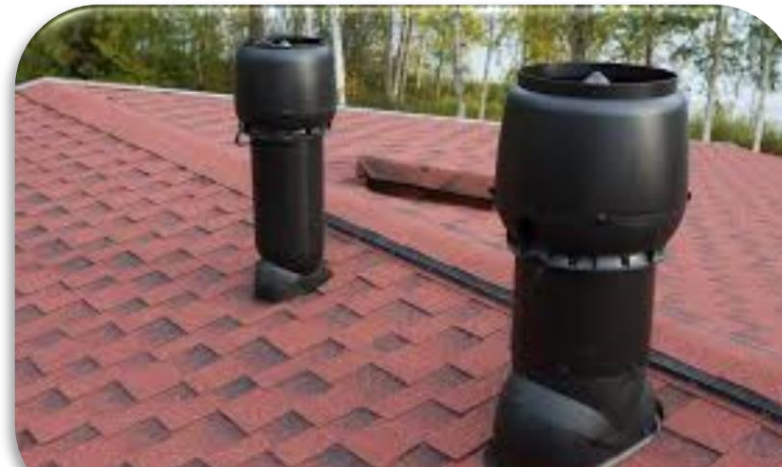
Фановый и вентиляционный выход
